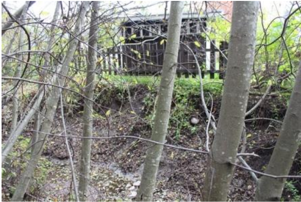
Kuva 34. Vehkojanpuiston puro ja latva-alueen voimakasta eroosiota. (Kuva: Minna Sawkins)
