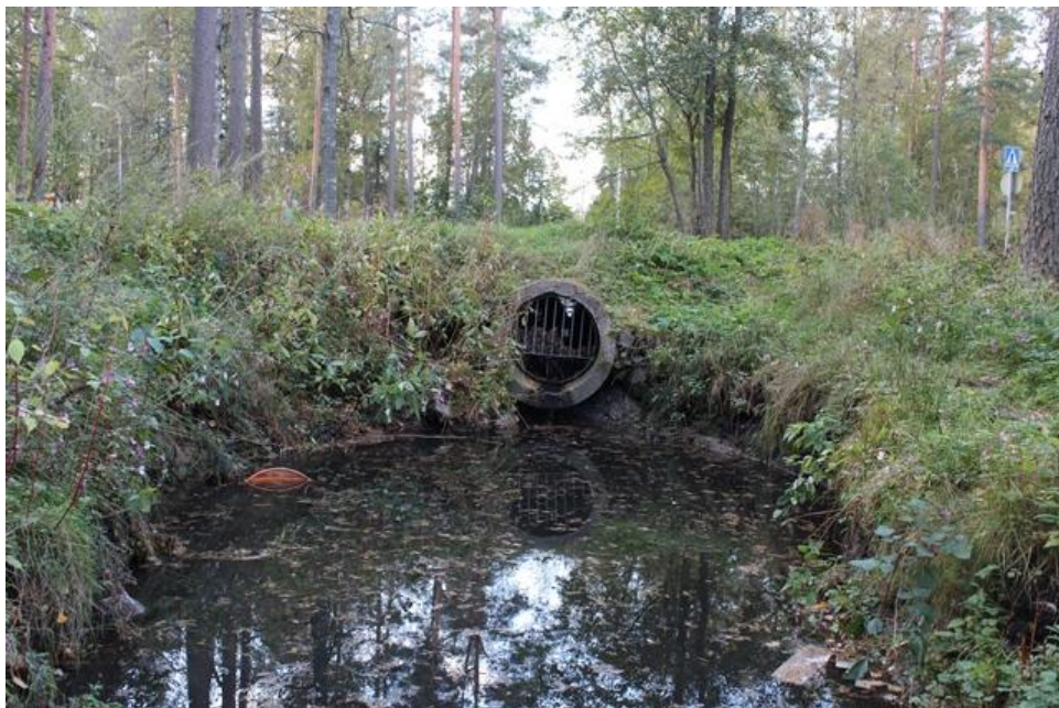
Kuva 2. Talvisillanpuiston puron vesirajan yläpuolella oleva ojarumpu. (Kuva: Minna Sawkins)
