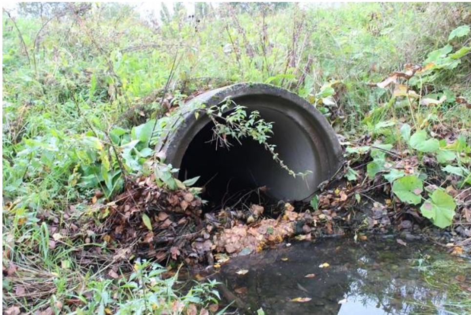
Kuva 1. Martinniityn puron kasvillisuuden tukkima tierumpu. (Kuva: Minna Sawkins)
