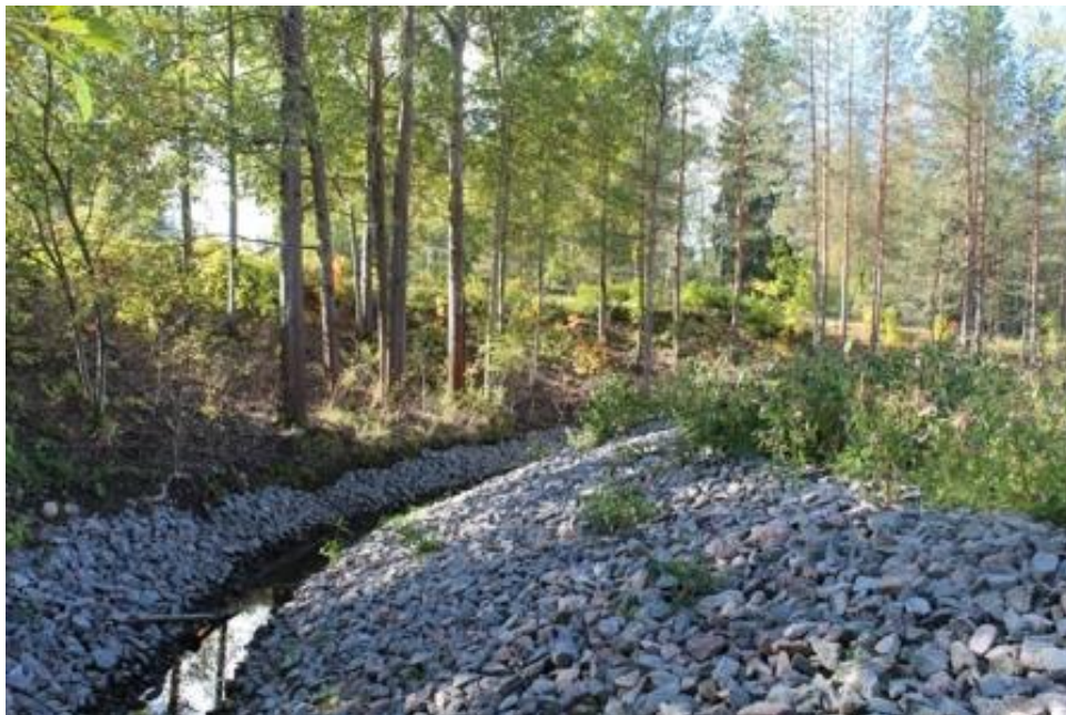
Kuva 30. Talvisillanpuiston puron yläjuoksun kunnostettua ja kivettyä puro-osuutta. (Kuva: Minna Sawkins)
